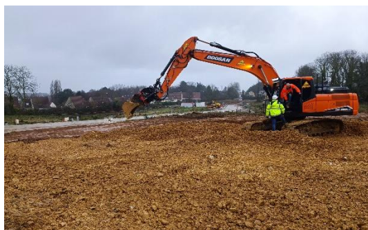
Chantier Artémis Phase 2 - décembre 2024
