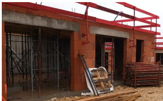
Chantier Artémis Phase 1 - décembre 2024
