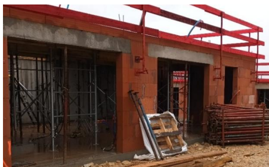
Chantier Artémis Phase 1 - décembre 2024
