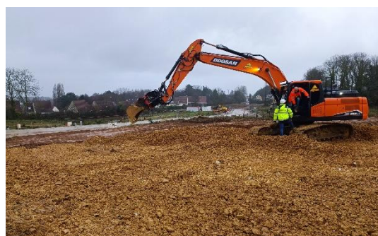
Chantier Artémis Phase 2 - décembre 2024
