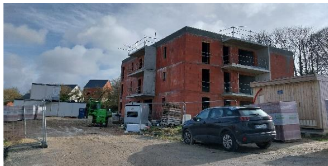
Chantier Artémis Phase 2
